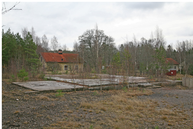
Endast grunden av Bersbo Metallgjuteri finns kvar. En brand ödelade byggnaden 2007.
